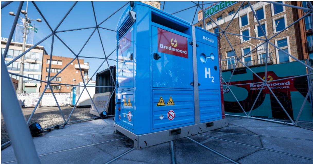
Figuur 5.2 Voorbeeld toepassing waterstofaggregaat Eurosonic, Groningen. Bron: Bredenoord .
